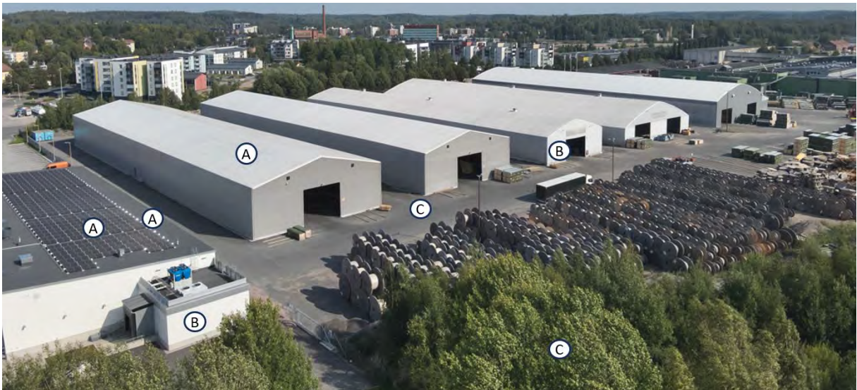
Kuva 55. Versowood Oy:n varasto- ja hallirakennuksia. Edustalla Lidl:n rakennus, jossa aurinkopaneelit katolla. A: Erilaiset kattomateriaalit. B: Kasvillisuuden vaikutus seinän läheisyydessä. C: Kasvillisuuden vaikutus. (Vesa Vuorinen)
