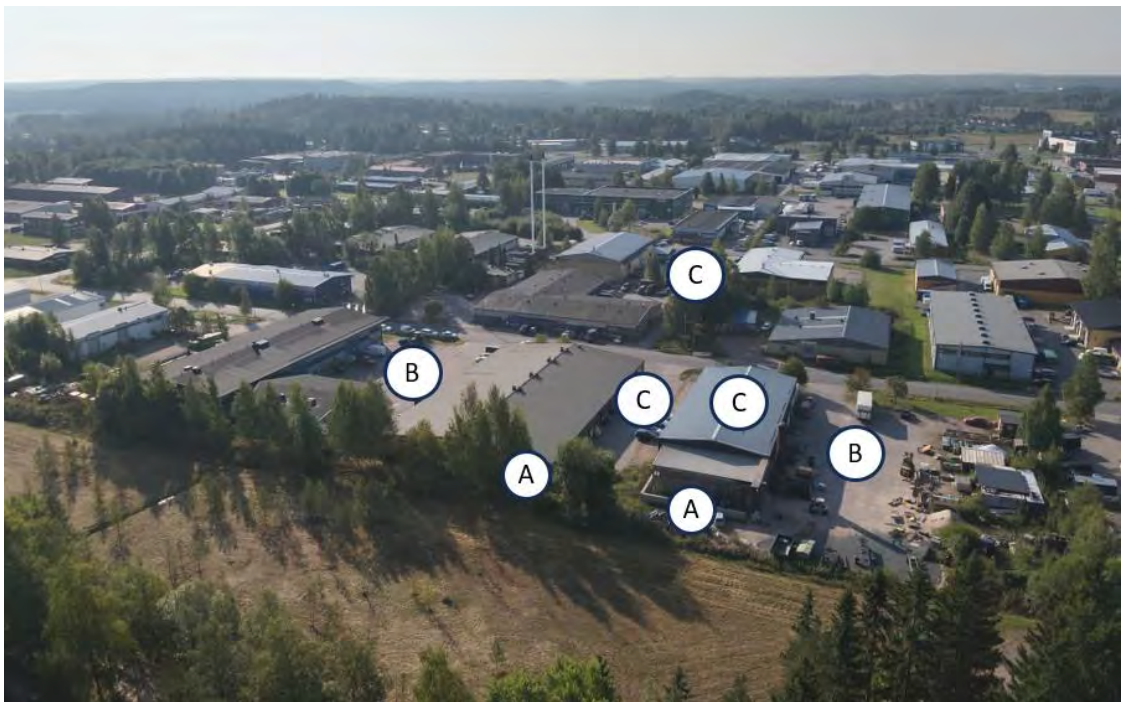
Kuva 27. Pohjoisesta etelään otettu kuva. A: Kasvillisuuden vaikutus pohjoisseinällä. B: Rakennuksen muodon vaikutus piha-alueeseen C: Kasvillisuuden vertailu koviin pintoihin (asfaltti ja katto) (Vesa Vuorinen)
