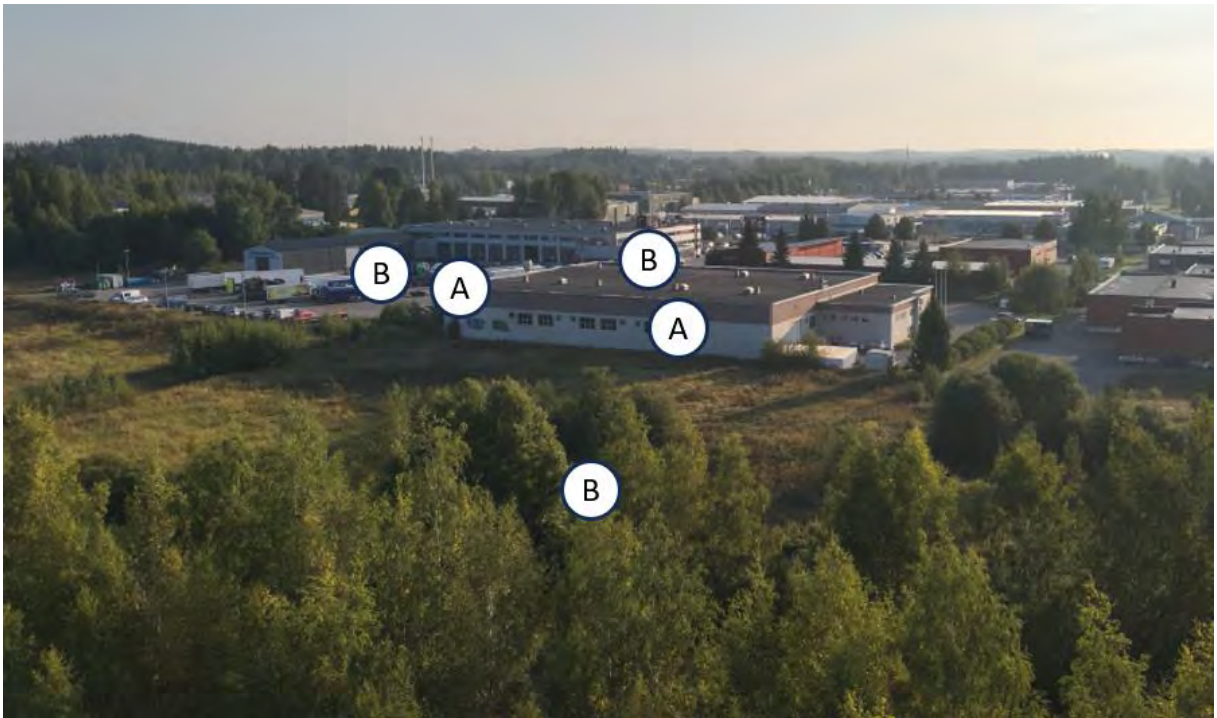
Kuva 32. Pohjoisesta etelään otettu kuva. A: Kasvillisuuden vaikutus länsiseinällä. B: Kasvillisuuden vertailu koviin pintoihin (asfaltti ja katto) (Vesa Vuorinen)
