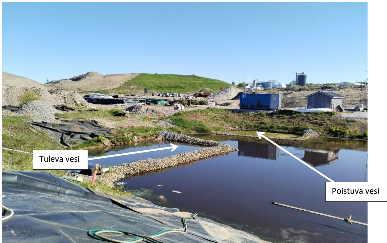
Kuva 1. Karanojan jätteenkäsittelyalueen vuonna 2002 rakennettu tasausallas. Taustalla näkyy jätetäyttöalueita, joilta kerätään vesiä tasausaltaaseen. Kuva: Josefiina Ruponen, 2022
