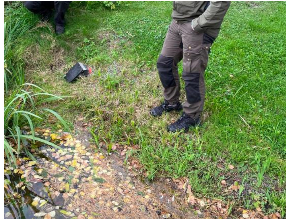
Ylivuotoputki 5 sijaitsee aivan rannassa, korkeamman vedenkorkeuden aikaan todennäköisesti veden alla. Putken sulkuluukku ei mahdu sulkautumaan täysin runsaan nurmikasvuston vuoksi. Kuva: Jutta Pantsu
