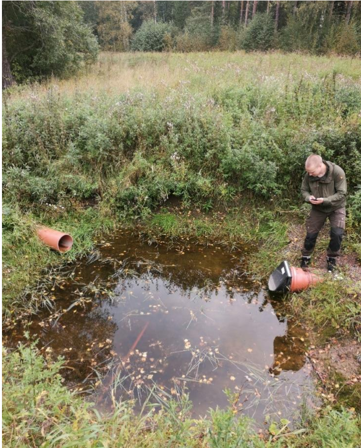
Jätevesien ylivuotoputken (ylivuotoputki 3) purkupaikalla on pienimuotoinen allas, josta johdettu putki viereiseen Myllyjoaan. Oja muutamia metrejä kuvasta vasemmalle. Kuva: Jutta Pantsu
