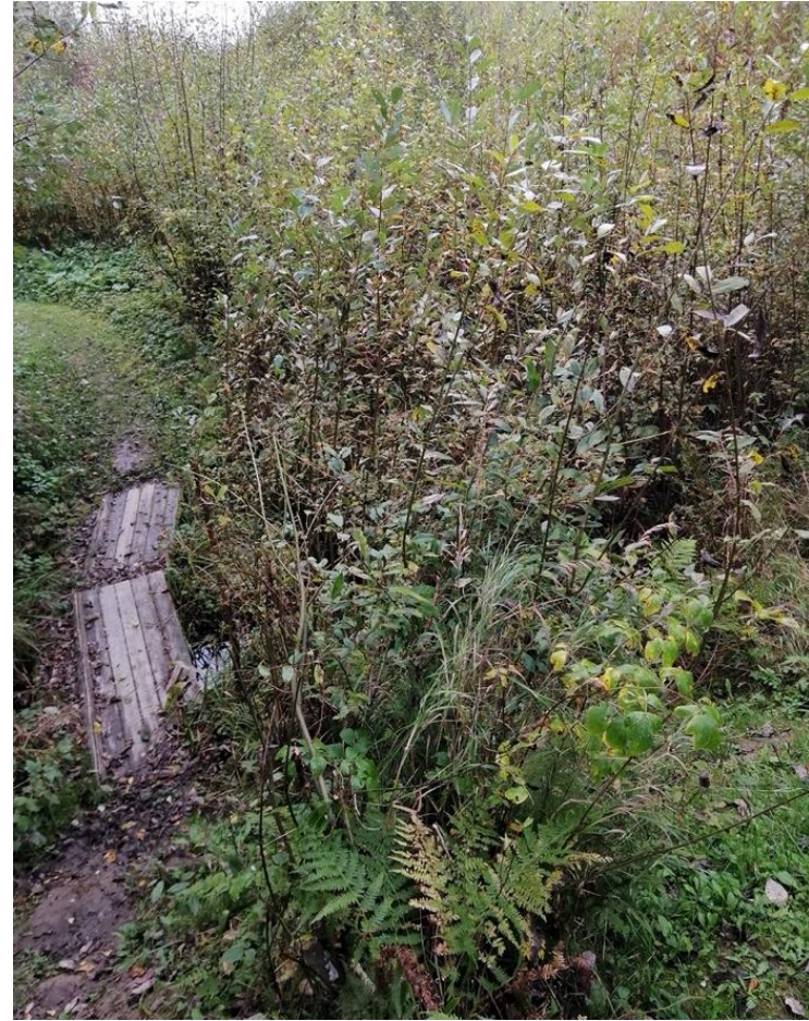
Purkupiste 4 on kahden ojan risteyskohta, jossa kasvillisuus on hyvin runsasta ja ojat suhteellisen matalia. Alueella on virkistyskäyttöä. Kuva: Sari Järveläinen
