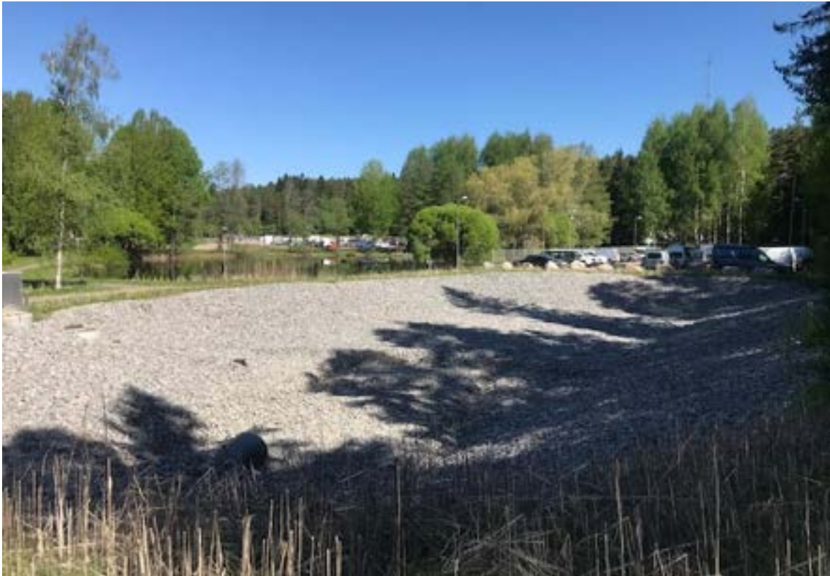
Kuva 11. Assi-sairaalan imeytysaltaaseen johdetaan hulevesiä sairaalan alueelta.
