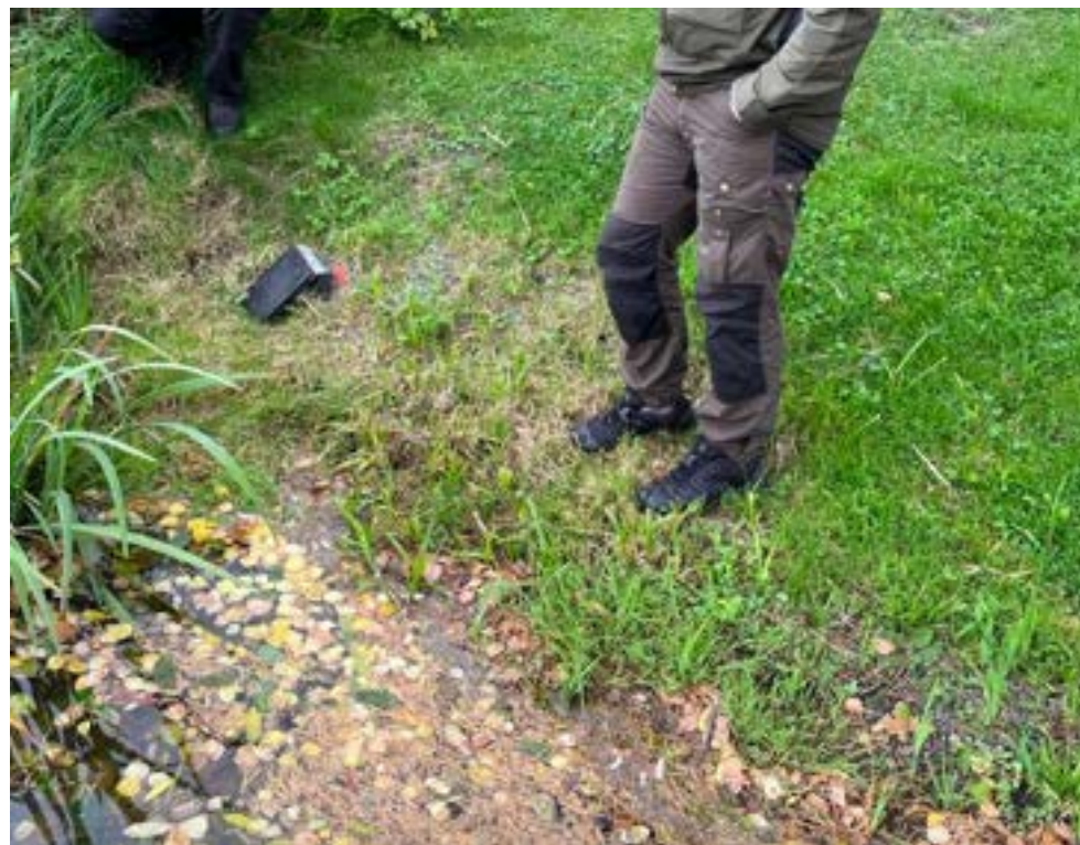
Ylivuotoputki 5 sijaitsee aivan rannassa, korkeamman vedenkorkeuden aikaan todennäköisesti veden alla. Putken sulkuluukku ei mahdu sulkautumaan täysin runsaan nurmikasvuston vuoksi. Kuva: Jutta Pantsu
