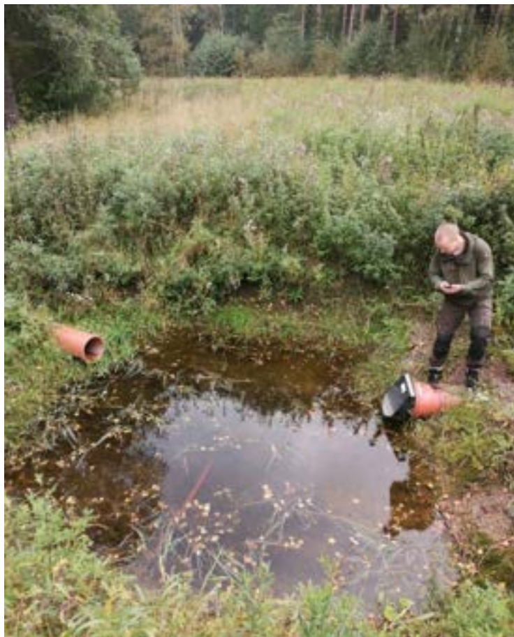
Jätevesien ylivuotoputken (ylivuotoputki 3) purkupaikalla on pienimuotoinen allas, josta johdettu putki viereiseen Myllyjojaan. Oja muutamia metrejä kuvasta vasemmalle. Kuva: Jutta Pantsu
