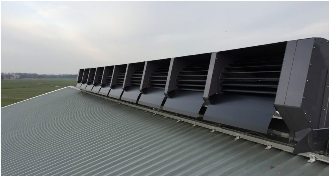
Kuva 5. Katon harjalle asennettu RB2 pientuulivoimajärjestelmä. (RidgeBlade, n.d.)
